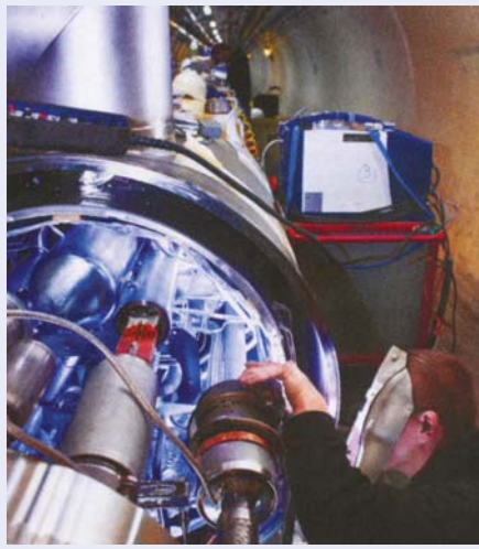
مرتبطة ببعضها : يقوم عامل بلحم مغنطيسين ذوي ناقلية فائقة في مصادم LHC.
